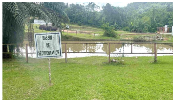
Bassin de sédimentation, contre la pollution des sols et des eaux
