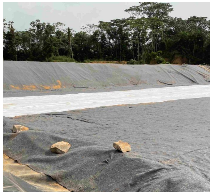
Vue de l'alvéole N° 6 avant sa mise en service
