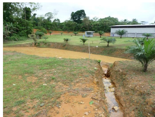
Figure 2: Evacuation des eaux de ruissèlements vers le bassin
