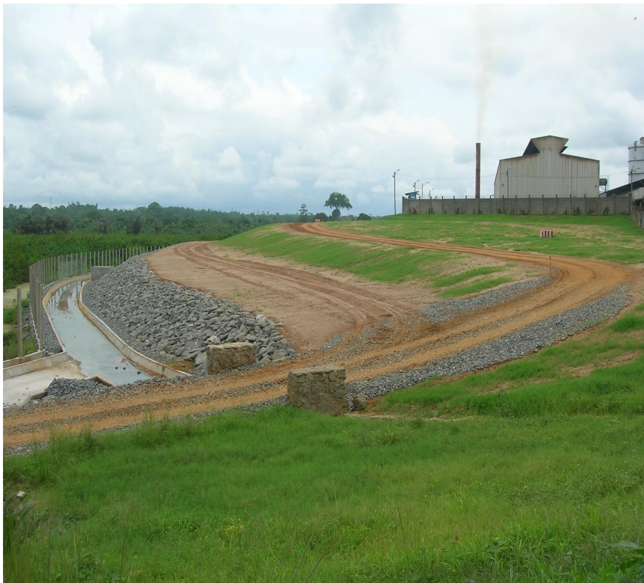
Figure 41: Une vue de l'ancienne décharge réhabilitée
