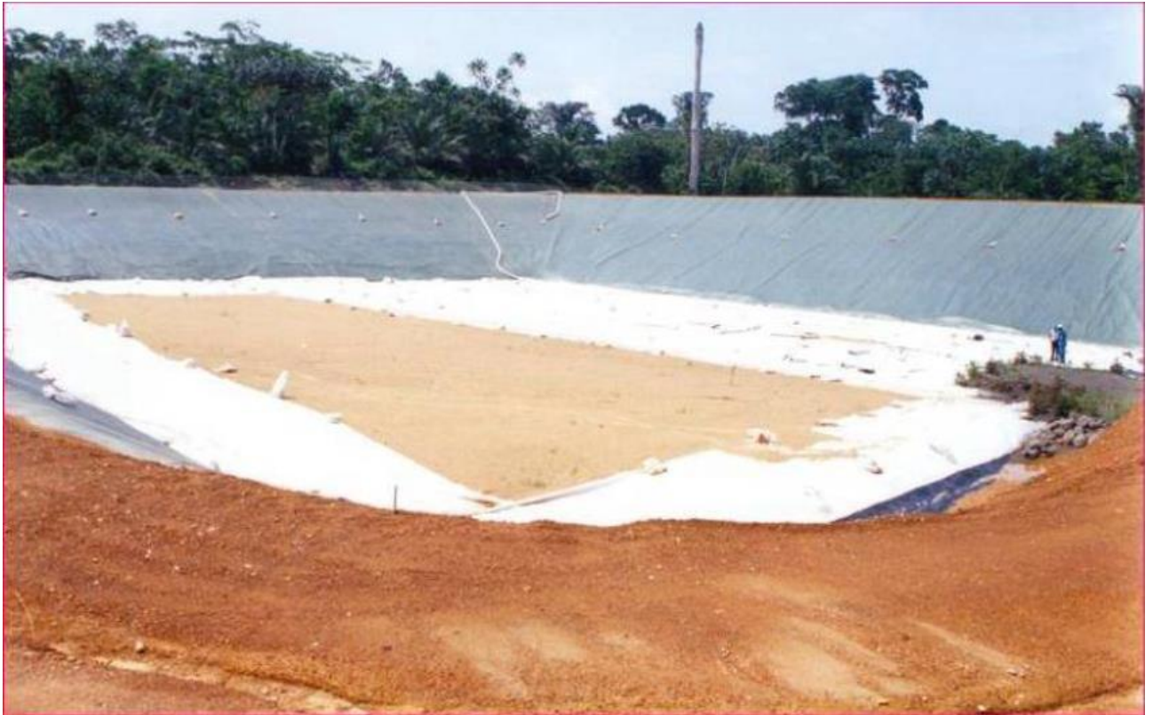
Figure 40: phase de construction d'un casier au CSDU
